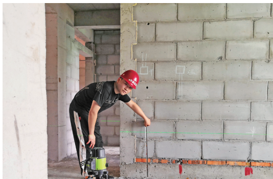
土木工程专业实习
